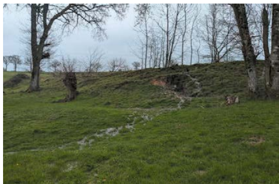
Chaussée déstructurée par les ragondins
